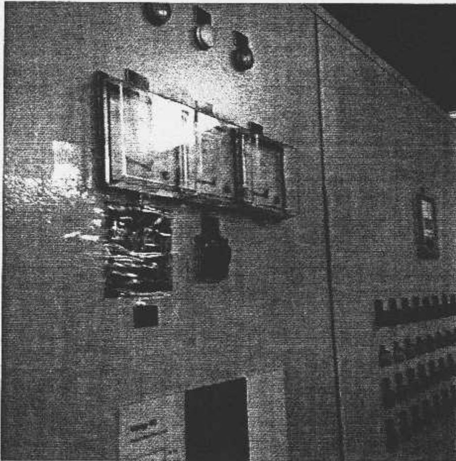
تصویر ۴: استفاده از قاب IP دار برای آمپر متر ها
